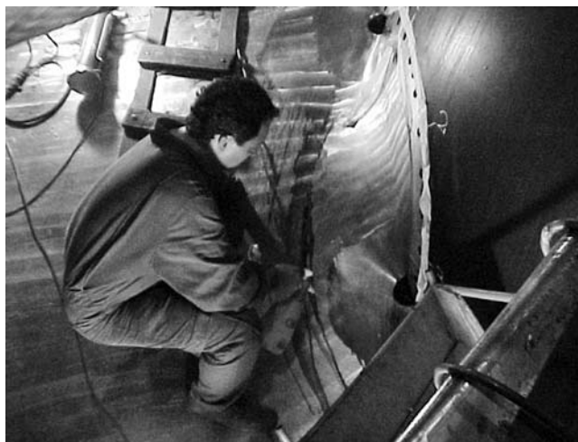
Inspección de álabes de turbina en la central hidroeléctrica de Yaciretá.
